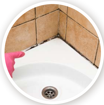
窗戶和牆壁的矽氧樹脂發黑，說明已發霉。
