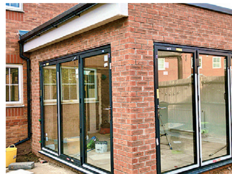
室外加建工程。
