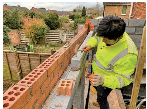
Anthony 在進行天台改造的工程。
